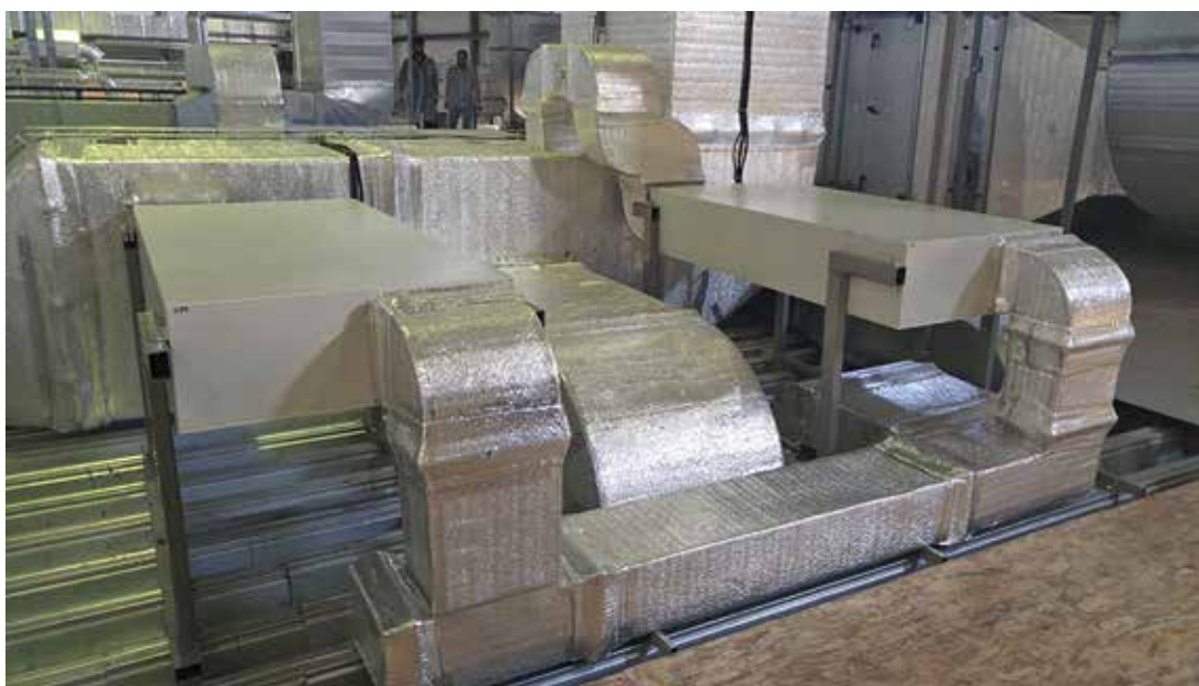
Рис. 5. Включение канальной установки 5УОВ с расходом воздуха в систему воздухоподготовки пищевого производства
