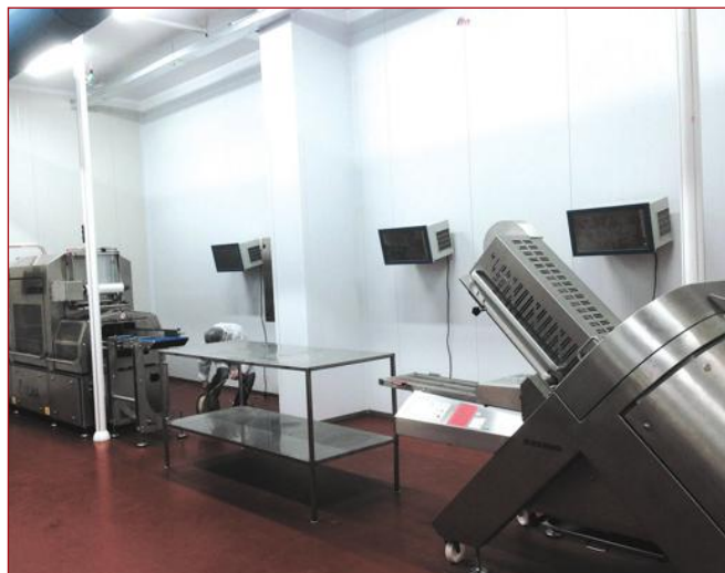
Фото 2. Автономные рециркуляционные установки «Поток» (цех нарезки и упаковки, ООО «Мясокомбинат Клинский»)
